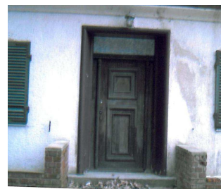
Drzwi wejściowe do byłego Domu Wczasowego Bajka II – ul. Promenada
