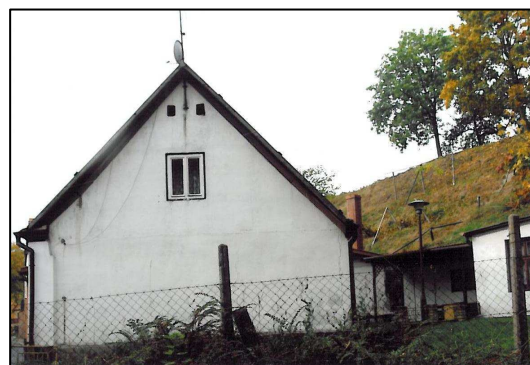
Ul. Chrobrego – od zawsze dom p. Jarzynów Wszystkie budynki otynkowano po 1945 r.
