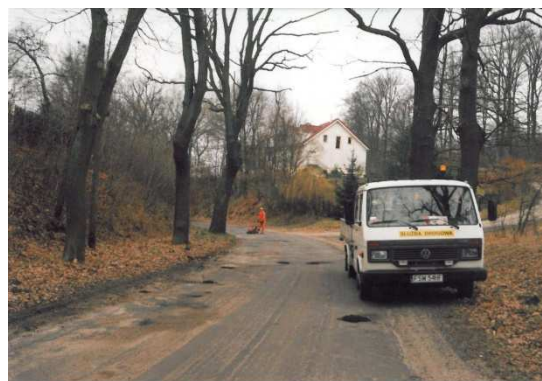
Ul. Sulęcińska – do Jemiołowa – „remont” pozorny plackami asfaltu
