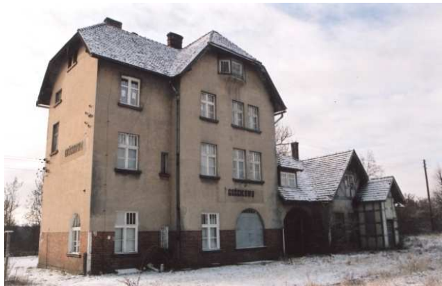
Budynki PKP w Gościkowie.
