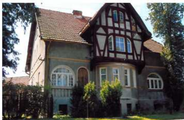
Foto R. Bryl VI/09 Budynek szachulcowy róg Paderewskiego - Podgórznej
