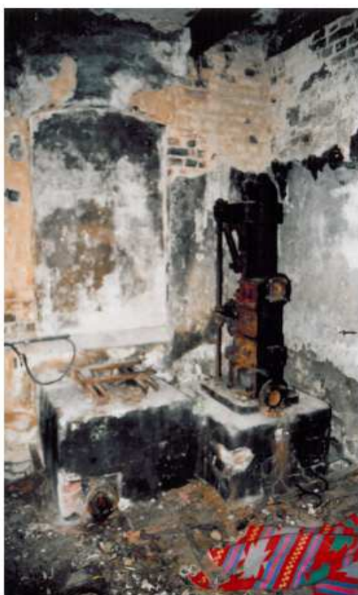
Foto R. Bryl Stan wnętrza hydropompy wskazuje na powstawanie meliny
