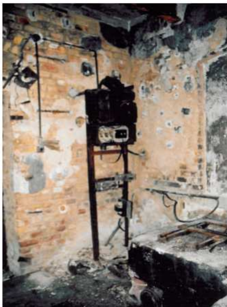
Foto R. Bryl Pomieszczenie hydropompy i Trafostacji30 23.10.08
