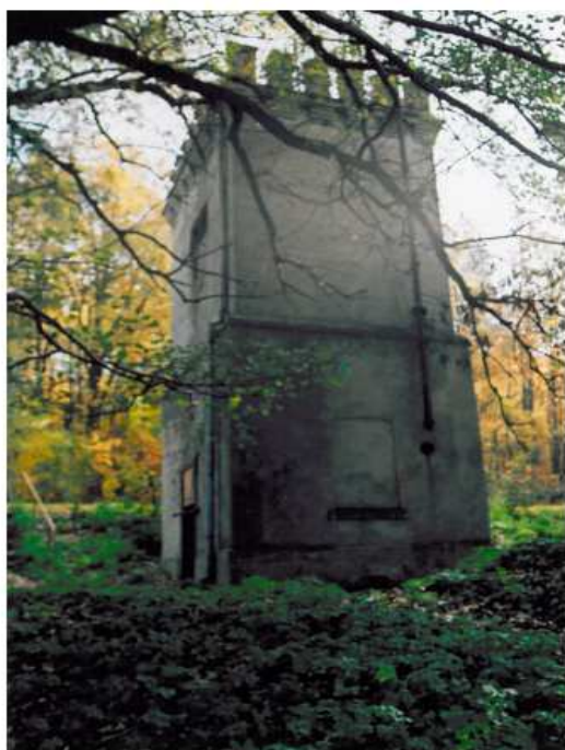
Foto R. Bryl Poniemiecka trafostacja i hydropompa w Łagowie
